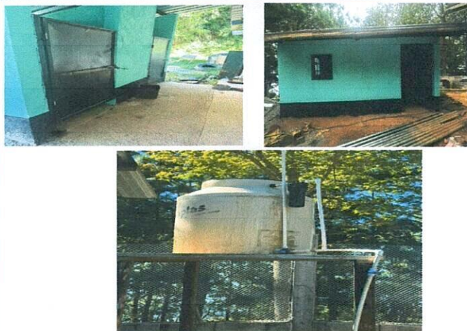
Foto1: finalización de remodelación de cocina, pintura y puerta, así mismo la finalización de la instalación de la tubería para el depósito de agua y baños, su instalación y su funcionamiento perfectamente.
